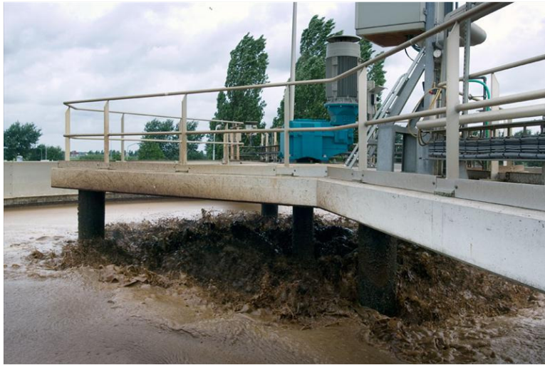
Astrumaer beluchter in bedrijf bij een afvalverwerkingsinstallatie
