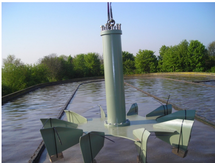
montage van een Astrumaer beluchter bij gevuld bassin
